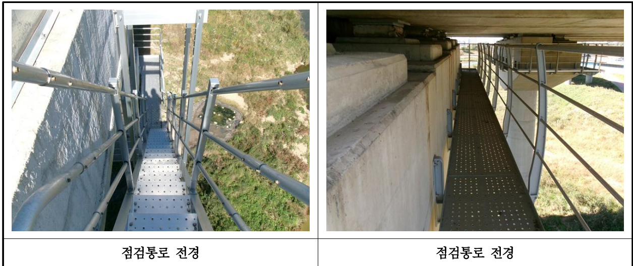
【사진 35.3.25】 교량 점검시설 전경
