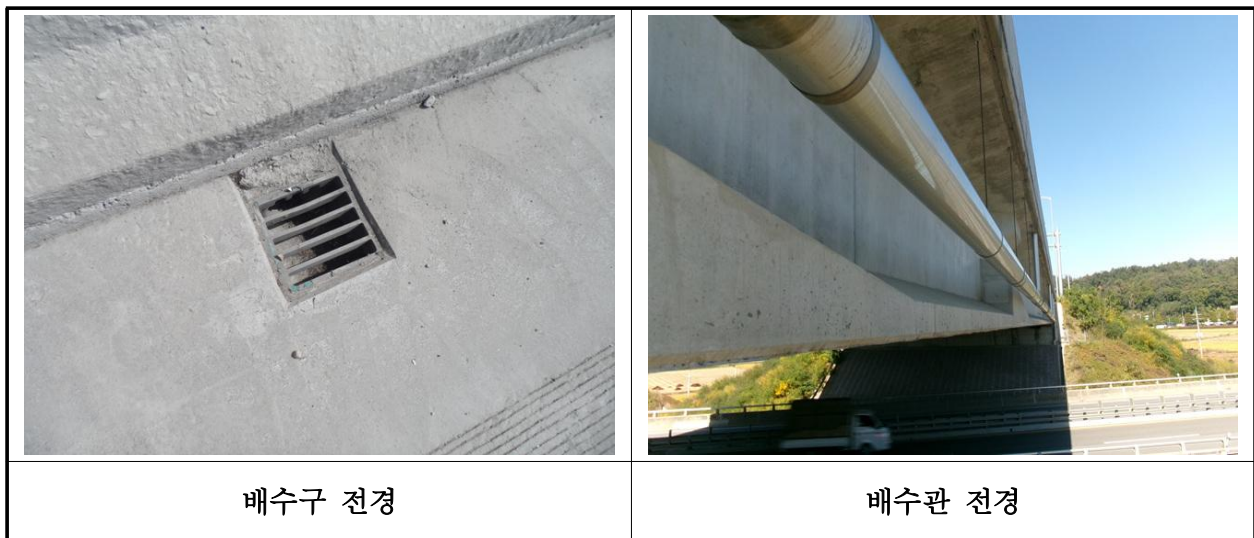
【사진 35.3.21】 배수시설 전경
