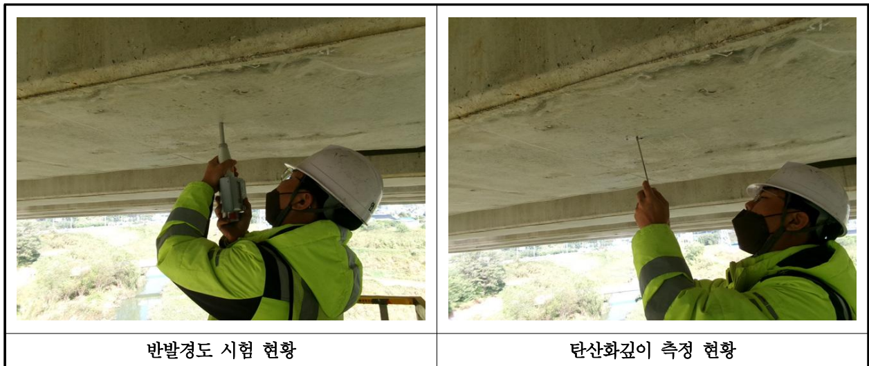
【사진 35.4.1】 콘크리트 내구성조사 현황
