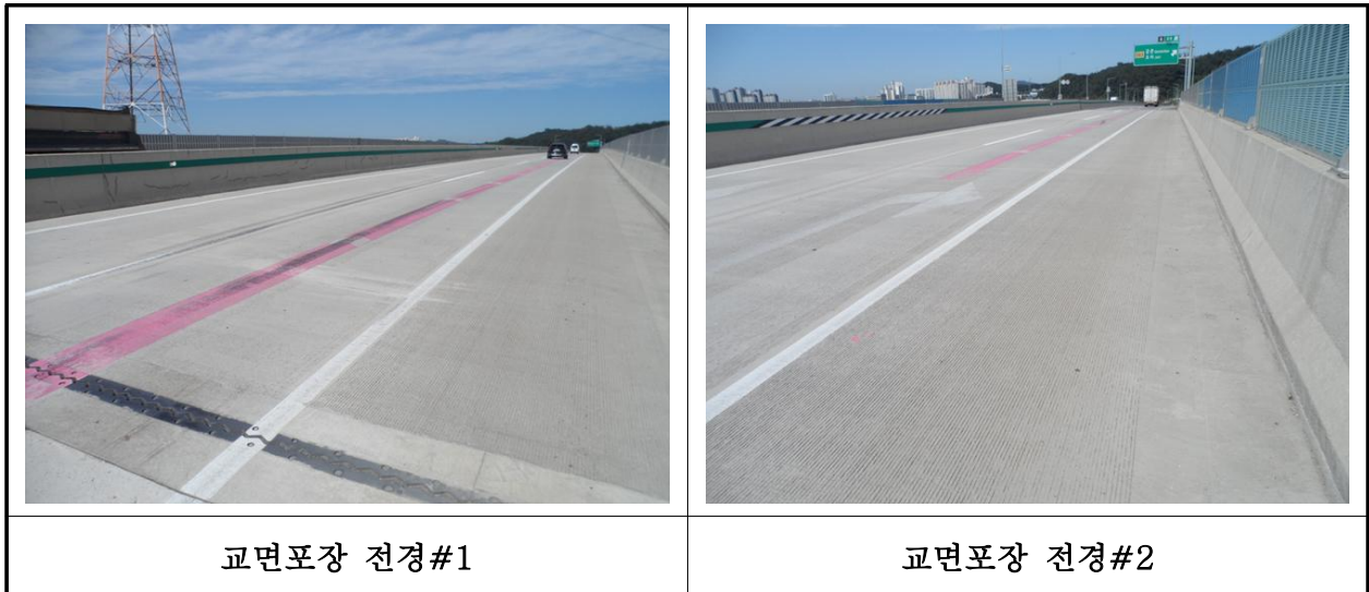
【사진 35.3.19】 교면포장 전경
