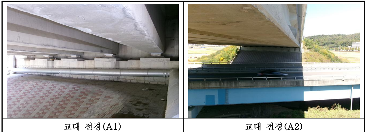
【사진 35.3.8】 교대 전경
