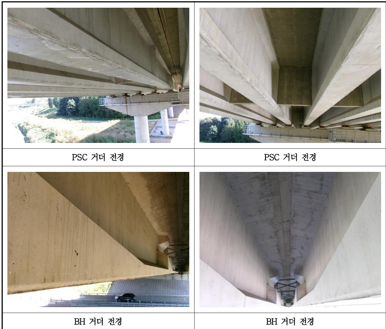
【사진 35.3.4】 거더 전경
