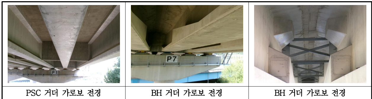
【사진 35.3.6】 가로보 전경
