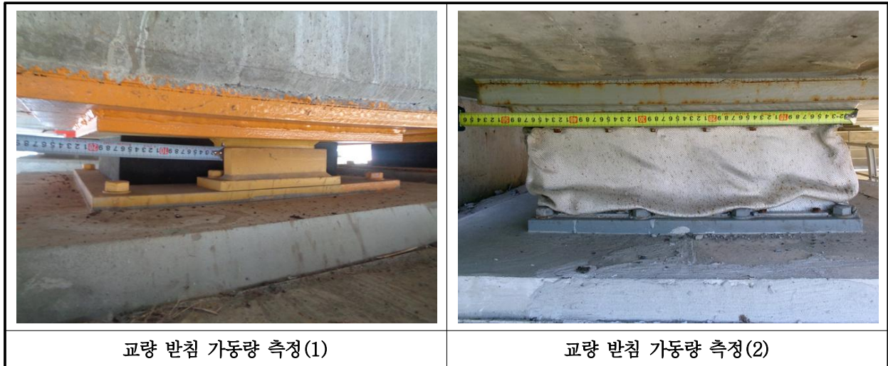
【사진 35.3.15】 교량받침 이동량 측정
