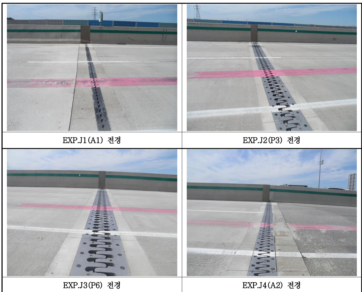
【사진 35.3.16】 신축이음장치 전경
