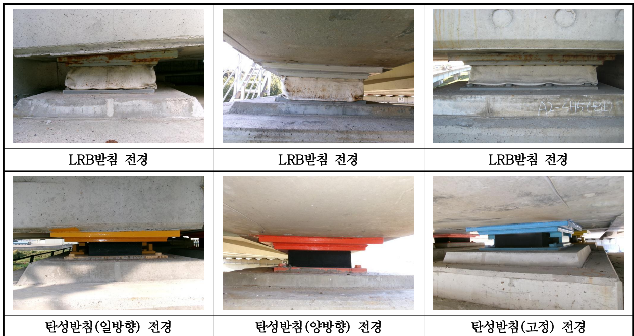
【사진 35.3.12】 교량반침 전경
